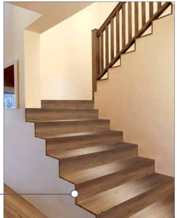
Dieses Beispiel zeigt die Zusammenstellung der Treppenelemente bei einer einseitig freistehenden Treppe, das heißt bei einer Treppe, die nur an einer Seite von einer Wand begrenzt ist.
