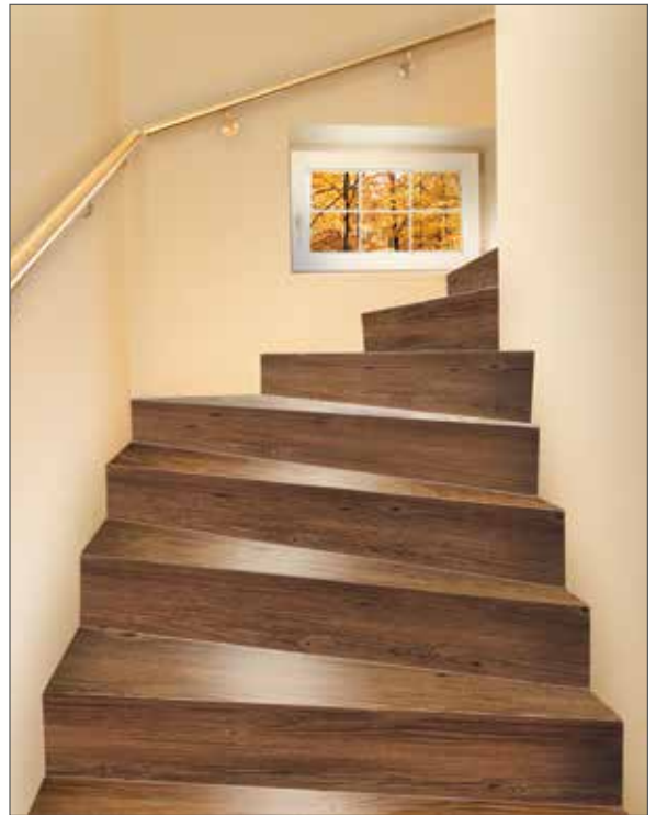
Das Beispiel zeigt die Zusammenstellung der Treppenelemente bei einer innenliegenden Treppe, das heißt bei einer Treppe, die an beiden Seiten von einer Wand begrenzt ist.
